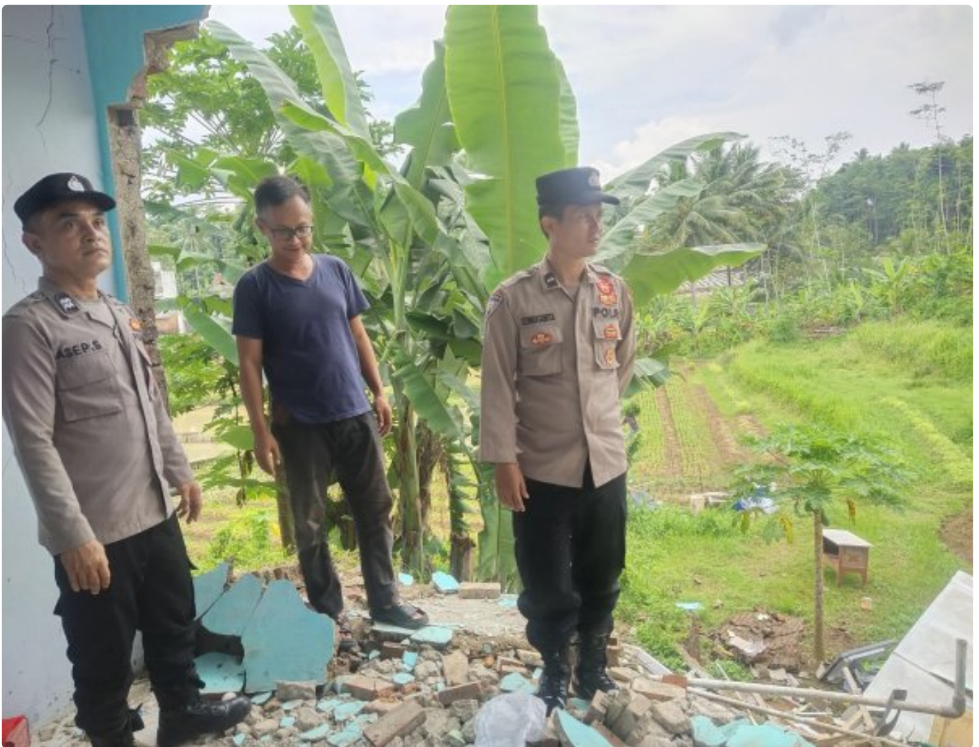
PERSONEL POLSEK MANONJAYA SAMBANGI LOKASI BENCANA RUMAH ROBOH AKIBAT LONGSOR DI DESA MARGALUYU
